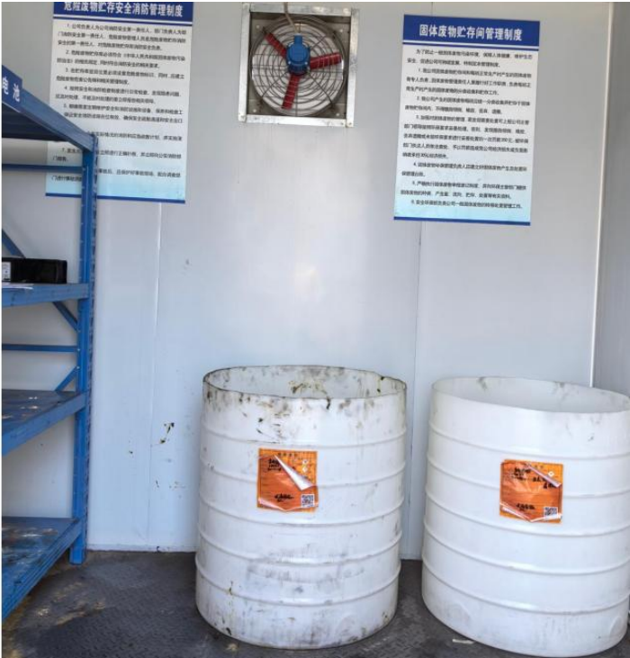
废电瓶（含废油桶）暂存间内布置情况
