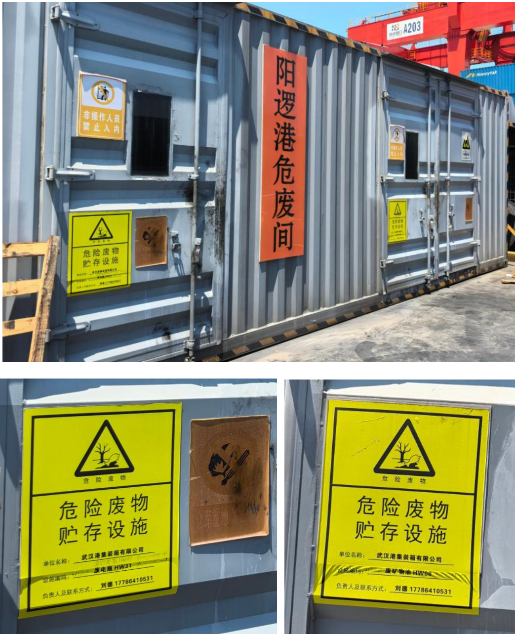
图 2.1-6 危废暂存间室外现场照片
