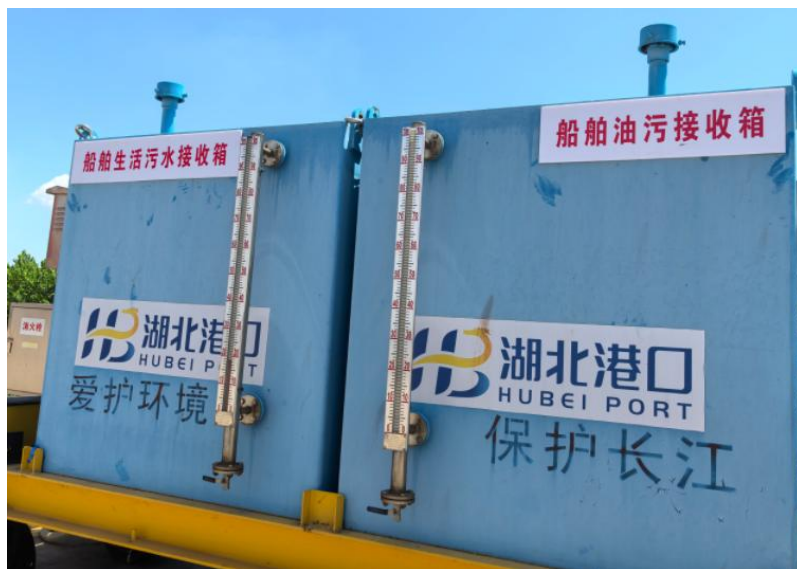
图 2.1-4 到港船舶污水收集箱
