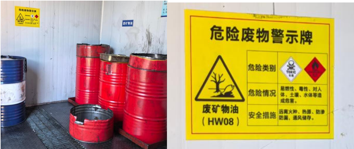
废矿物油暂存间室内摆放情况及贴墙标识
