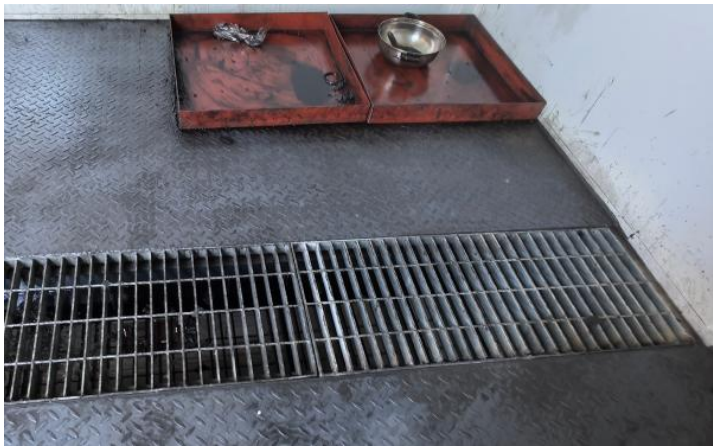
废矿物油暂存间地面导流槽
