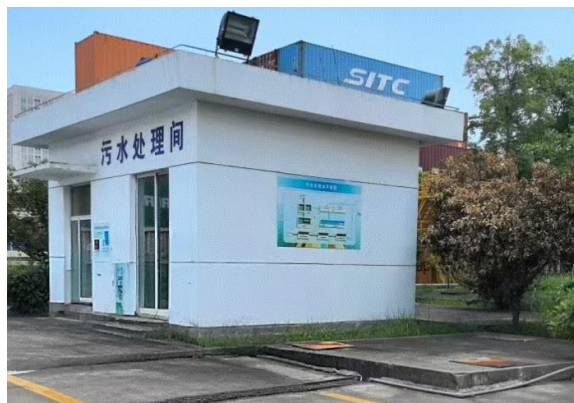
污水处理设备间
