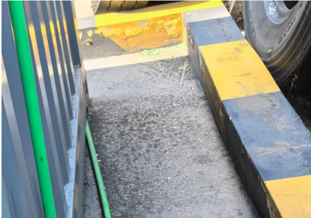
图 2.1-8 危废暂存间外部围堰
