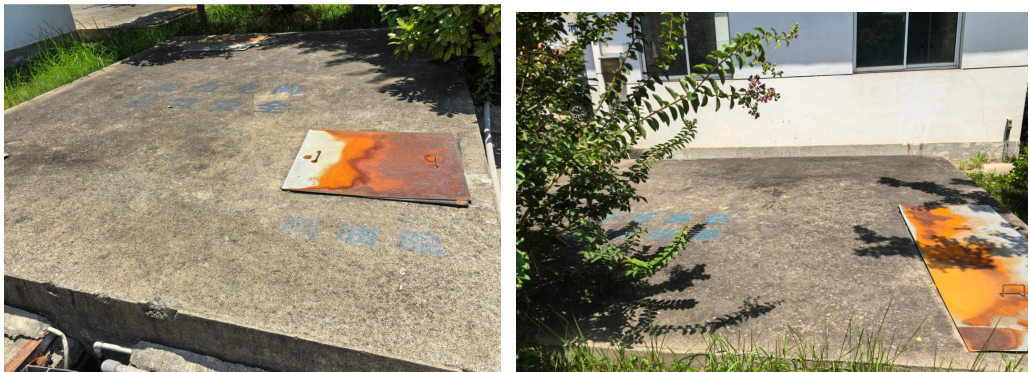
隔油池+调节池（絮凝沉淀）+污泥池、清水池（右）
